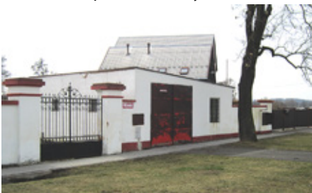
Původní stav zbrojnice před rekonstrukcí
